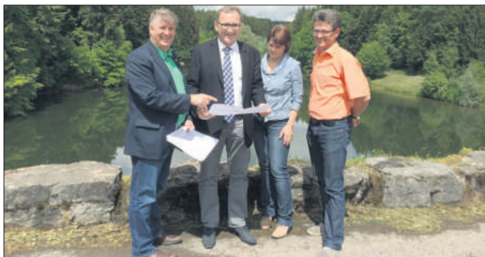
Der Eisenbachstausee wurde saniert: Bürgermeister Michael Segan, Verbandsvorsteher Georg Ruf, Geschäftsführerin Annegret Glombik und der Technische Betriebsleiter Melchior Rettenmeier haben sich vor Ort ein Bild davon gemacht. Bild: Privat
